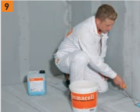
9 Applicare una mano di FERMACELL Primer nella zona della parete adiacente...
