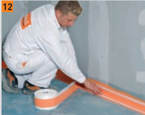
12 Premere il nastro sigillante FERMACELL nella guaina liquida ancora umida
