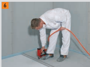
6 ...o graffe ad espansione (con punte divergenti) da 22 mm
