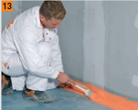
13 In un secondo passaggio ricoprire il nastro sigillante con FERMACELL guaina liquida
