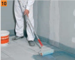
10 ... poi sul pavimento con un rullo
