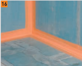
16 Se la sollecitazione di umidità è limitata, il sistema di impermeabilizzazione FERMACELL può essere applicato solo nella zona degli angoli e degli spigoli
