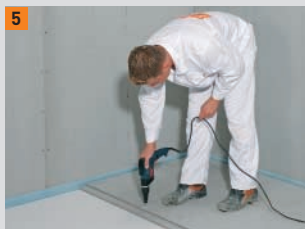
5 Fissaggio con viti Powerpanel ...
