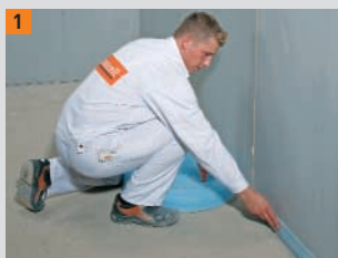
1 Posare le strisce isolanti perimetrali
