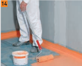
14 Applicare sul pavimento FERMACELL guaina liquida con un rullo, in due passaggi
