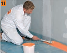
11 Applicare FERMACELL guaina liquida negli angoli con un pennello
