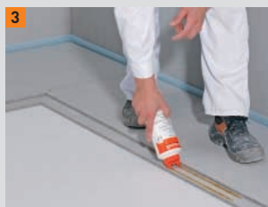
3 Applicare FERMACELL adesivo per sottofondi sulla battuta degli elementi
