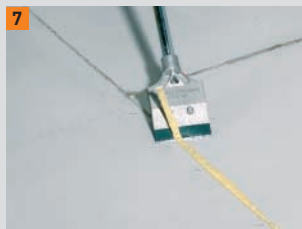
7 Dopo l'indurimento eliminare l'adesivo fuoriuscito
