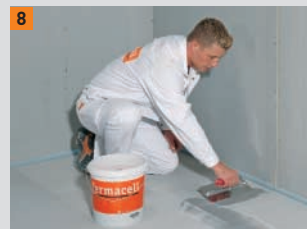
8 Se necessario stuccare i giunti e le teste delle viti (o delle graffe)
