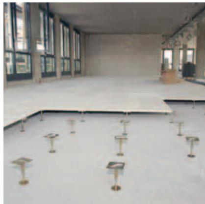
Pavimento sopraelevato a secco FERMACELL
