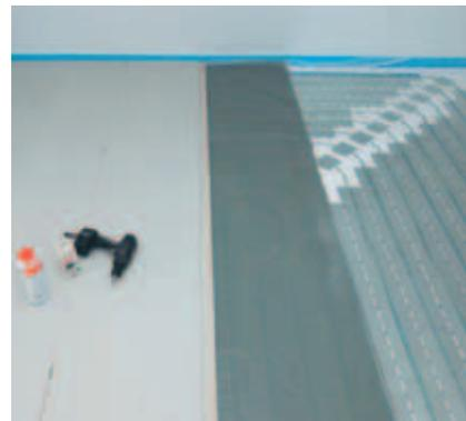
Se sopra il materiale livellante FERMACELL sono previsti dei sistemi di riscaldamento a pavimento, si dovrà prevedere uno strato di distribuzione del carico, utilizzando una lastra in gessofibra FERMACELL da 10 mm posata libera tra il materiale livellante e il riscaldamento a pavimento.
