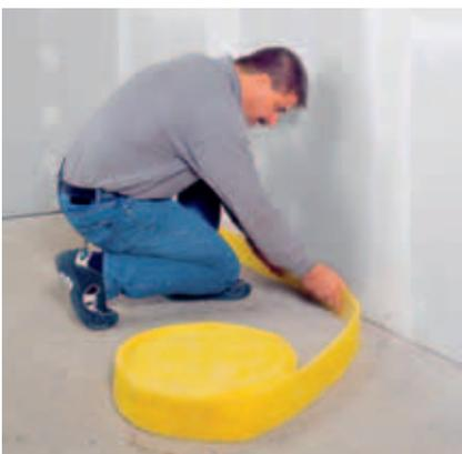
Fig. 1 – Posa delle strisce perimetrali isolanti
