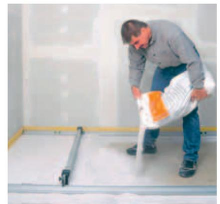
Fig. 3 – Riempimento con il livellante granulare
