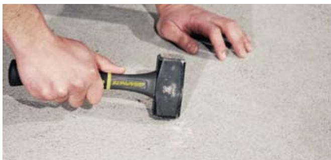
4 Verificare la consistenza della superficie del massetto per garantire la massima adesione della nano-membrana impermeabilizzante.
