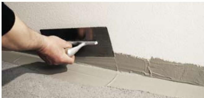
3 Fissare **AquaStop 70** sull'eco-impermeabilizzante fresco seguendo il giunto parete-pavimento.
