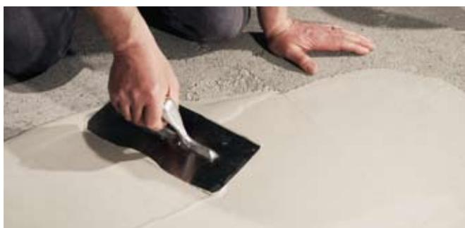
5 Durante la stesura della prima mano di **Nanoflex®** ricoprire la parte orizzontale di **AquaStop 100** precedentemente fissato a pavimento.
