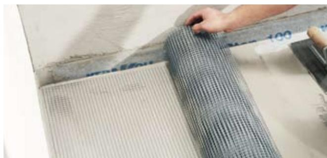
10 A prodotto indurito, dopo aver rimosso l'eventuale condensa superficiale, applicare la seconda mano di **Nanoflex®**. Realizzare uno spessore continuo e uniforme di circa 3 mm a totale copertura della trama di **AquaForm AR1**.
