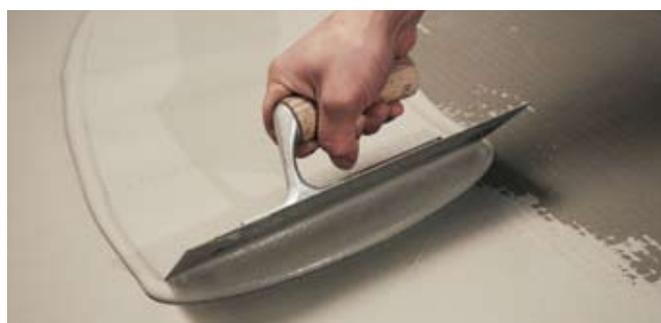
11 Durante la stesura della seconda mano di **Nanoflex®** ricoprire accuratamente la parte verticale di **AquaStop 100** fissato a parete.
